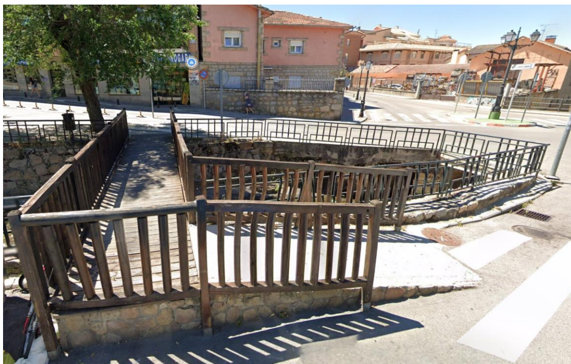
Foto 5.- Pasarela peatonal sobre la canalización del arroyo del Cortecero y cruce de la calle Cañada de los Toros.
