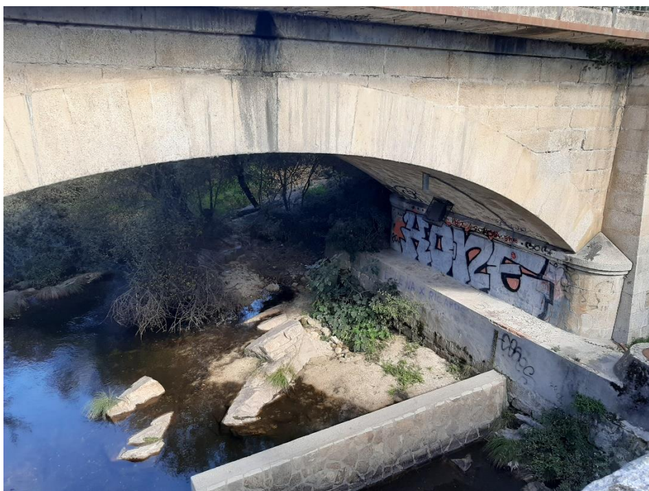
Foto 2.- Puente de la calle Real sobre el río Manzanares, junto al Puente Viejo. Aforador con limnómetro.
