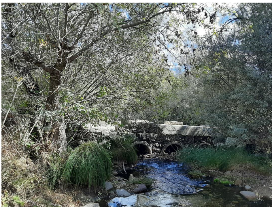
Foto 8.- Badén sumergible en el río Manzanares en las calles del Tranco/Virgen de los Peligros. Con frecuencia el agua pasa por encima, impidiendo el paso.
