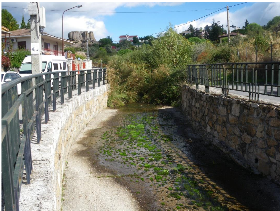
Foto 7.- Inicio de la canalización arroyo del Cortecero (hacia aguas arriba) a la altura del número 15 de la calle del Arroyo Cortecero
