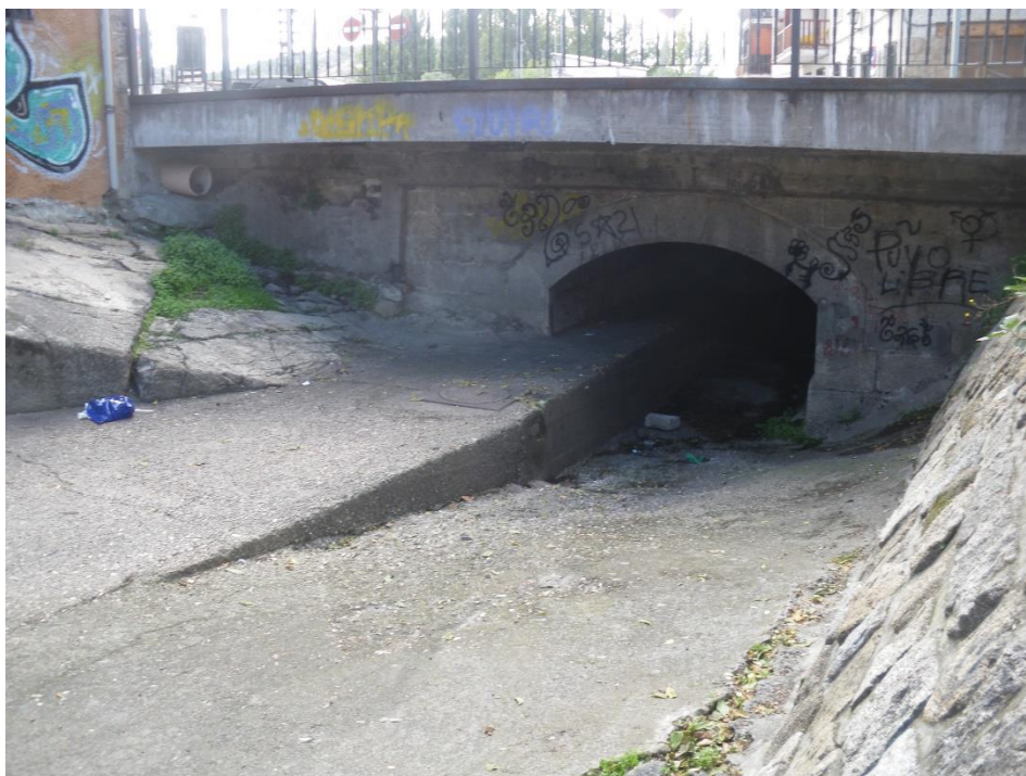
Foto 1.- Inicio del soterramiento del arroyo del Cortecero (hacia aguas abajo), en calle Real.
